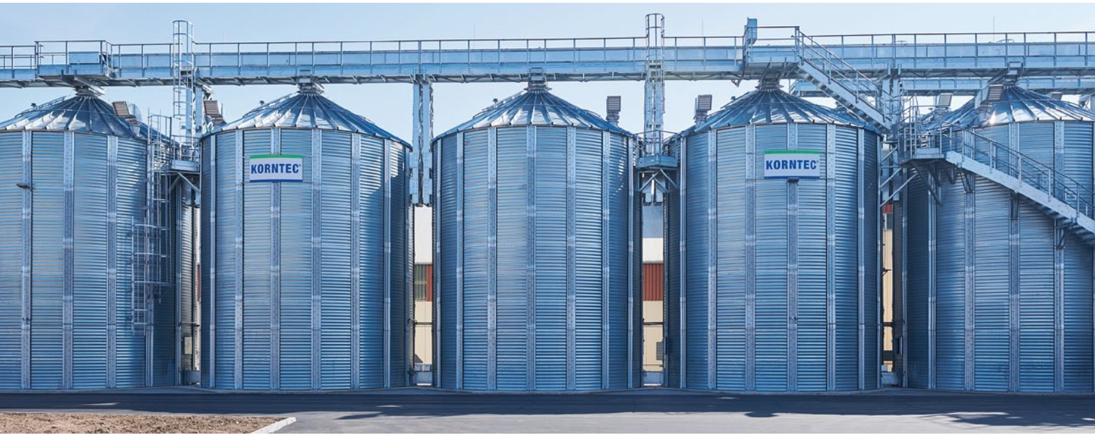
Getreidesiloanlage mit Aufstiegstreppe
